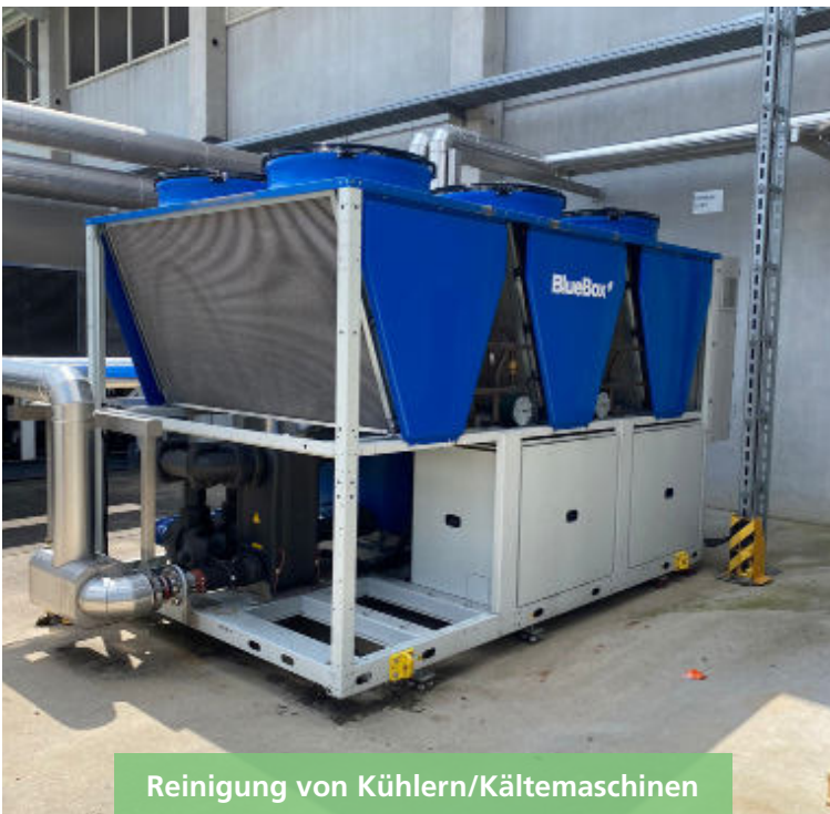
Reinigung von V-Kühlern
